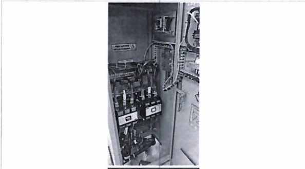
Cambio de cableado de relevadores
