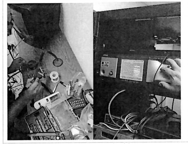
Se adaptan algunos cables, debido a que estaban cortos, y se cambian conectores por nuevos, y se retira el procesador de audio análogo, debido a que prese
